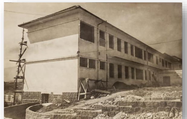
Construção do Pavilhão de Tisiologia, 1953
